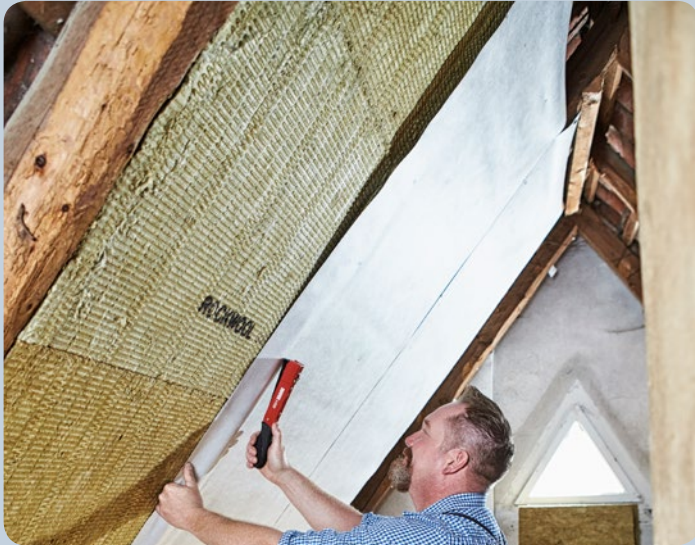
Folie beim Dachbodenausbau einfach befestigen.
