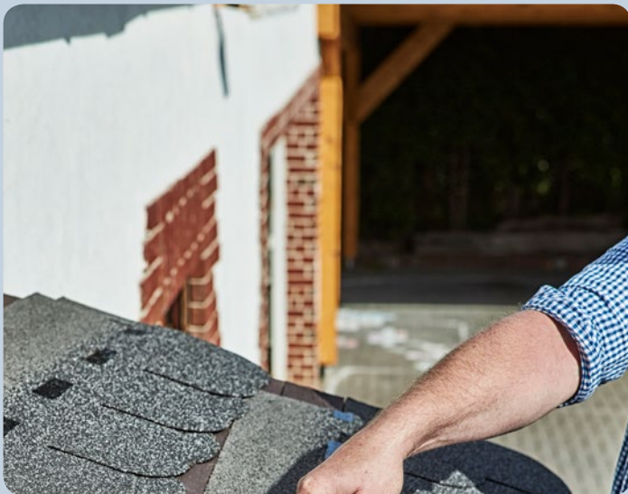
Schnelles Befestigen von Bitumenschindeln.
